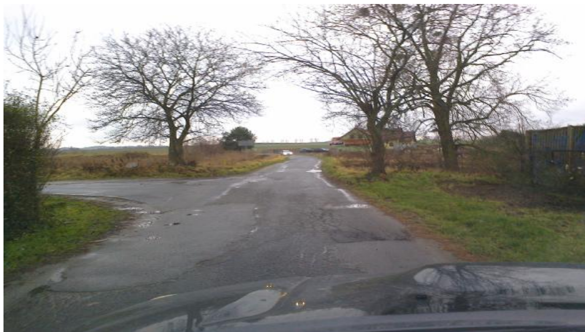
Stan nawierzchni jezdni i zawyżone pobocza w m. Budczyce .
